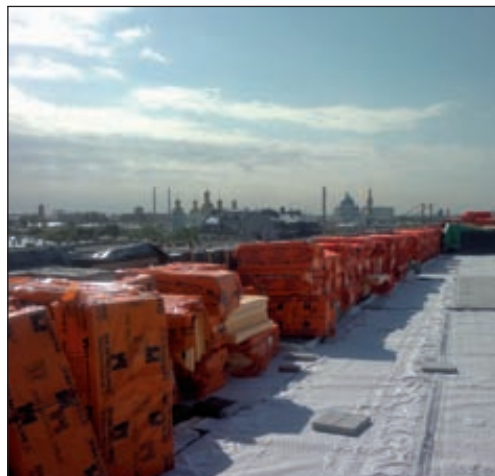
Крыша 2-ой сцены Мариинского театра в Санкт-Петербурге
