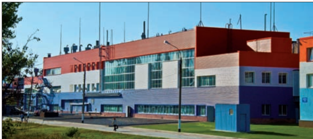
Корпус оксиэтилирования ООО «Завод синтанолов» / НОРКЕМ™
