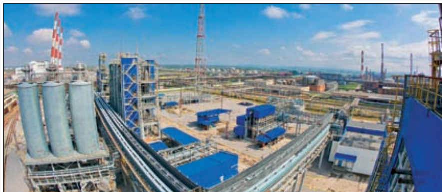
Промышленная площадка ОАО «Газпром нефтехим Салават»
