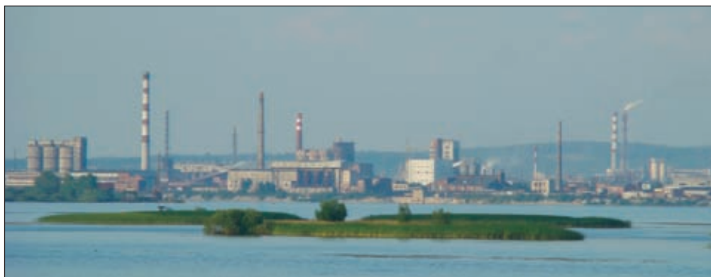
«Азот» (г. Березники) завершил плановый капитальный ремонт оборудования
