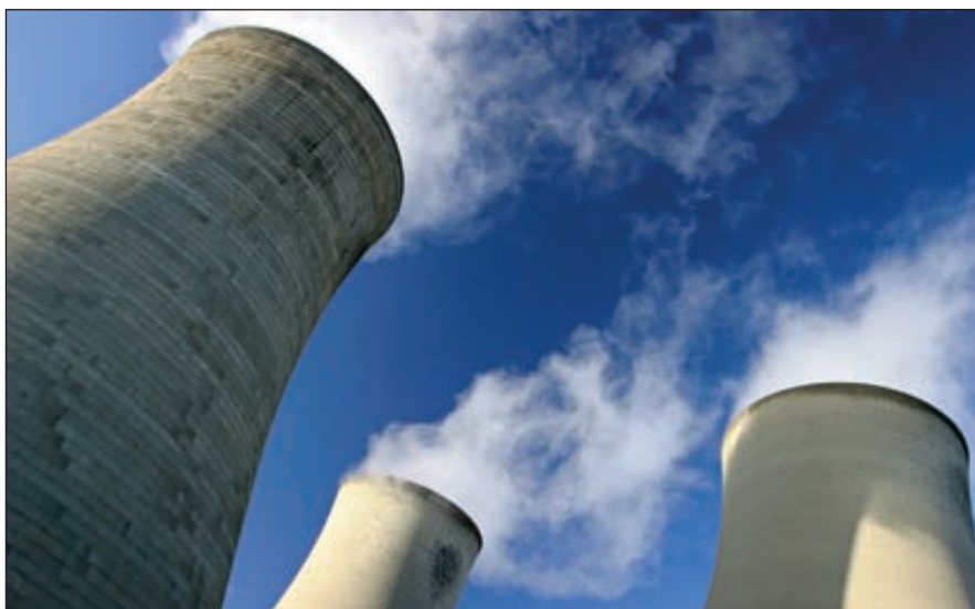
Генераторы электроэнергии «НПО Кинематика» (Татарстан) с использованием низкопотенциального тепла градирен позволяют получать дополнительную энергию при охлаждении технической воды, в результате чего мощность на охлаждение воды в градирнях снижается на 10 %, заметно уменьшаются текущие расходы
