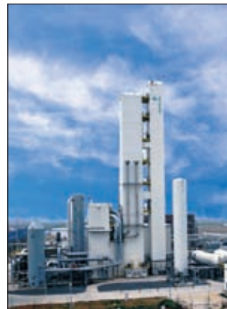
Завод по газификации угля Wison (Nanjing) Clean Energy, Нанкин (Китай)
