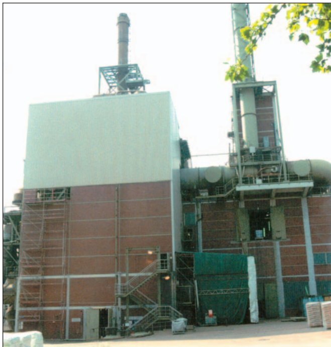
На этой установке по переработке сырья из руды по сульфат-технологии производится суспензия двуоксида титана
