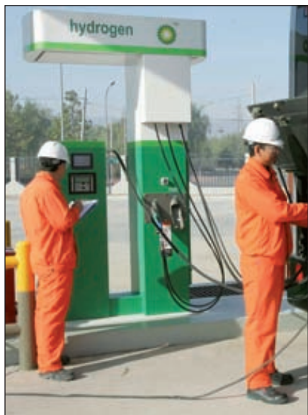
Водородная заправочная станция
