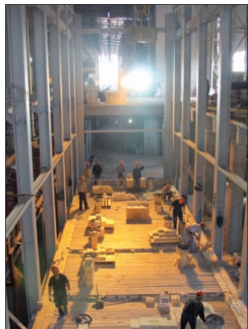
Монтаж печи для производства листового стекла ЗАО «Тракья Гласс Рус»
