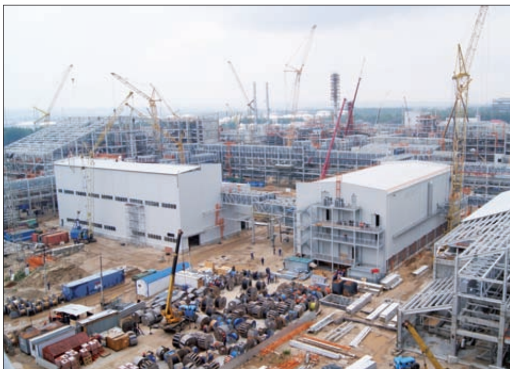
Строительная площадка «Русвинила», август 2013
