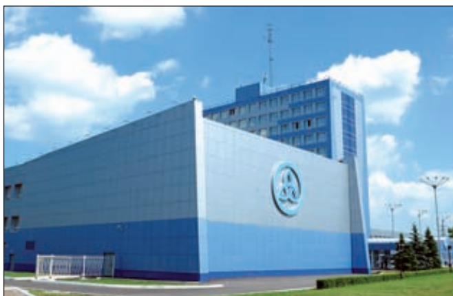
«Нижнекамскнефтехим» в 2016 году запустит этиленовый комплекс мощностью 1 млн т в год
