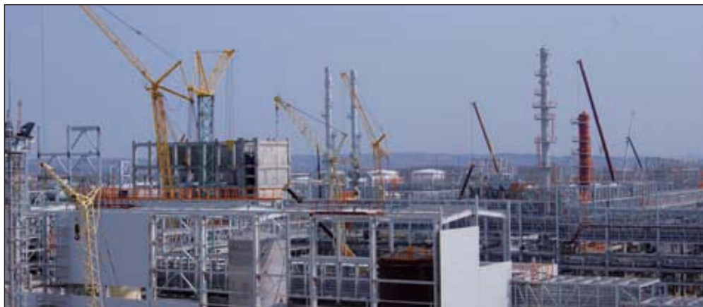
Строительная площадка «РусВинила», апрель 2013
