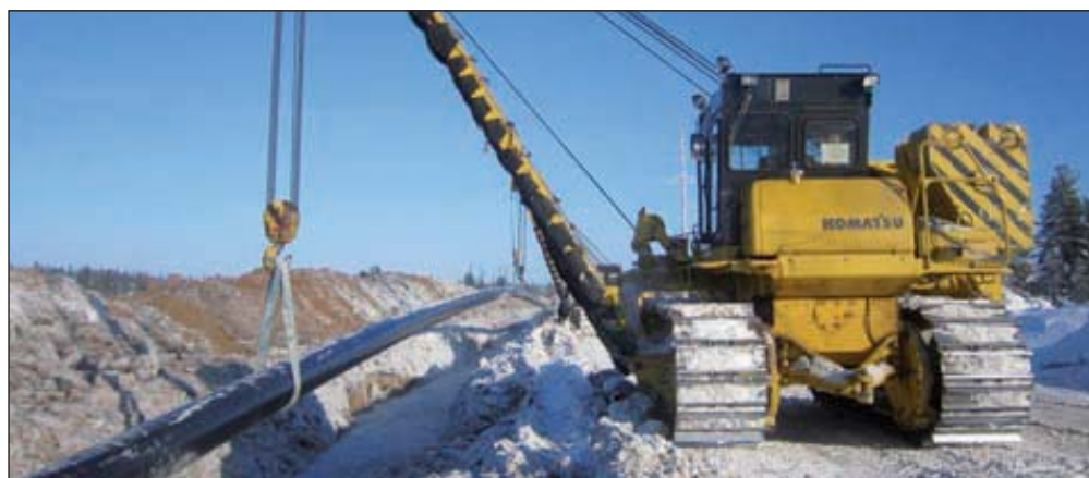
Укладка продуктопровода ШФЛУ Север – Север. «Сибур», 2013 г.
