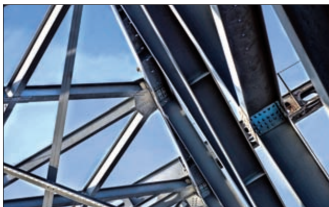
«ТехноНИКОЛЬ» развивает новое направление в области антикоррозионной защиты
