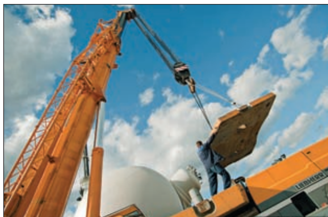
Строительство завода «Русвинил» в Кстово движется полным ходом
