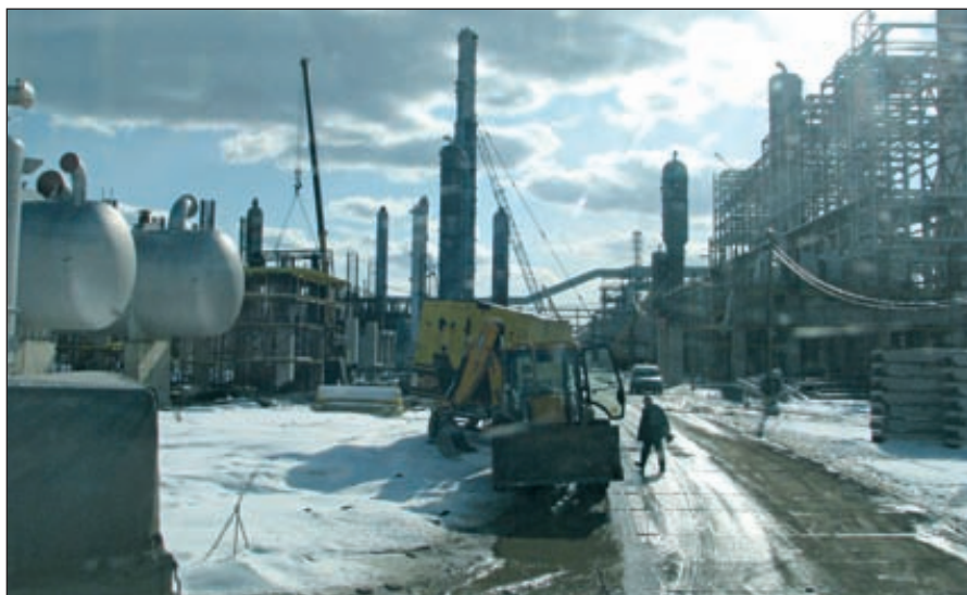
Из 29 российских НПЗ 5 запущено в довоенные годы, 6 построено до 1950 года, 8 введено в строй до 1960 года
