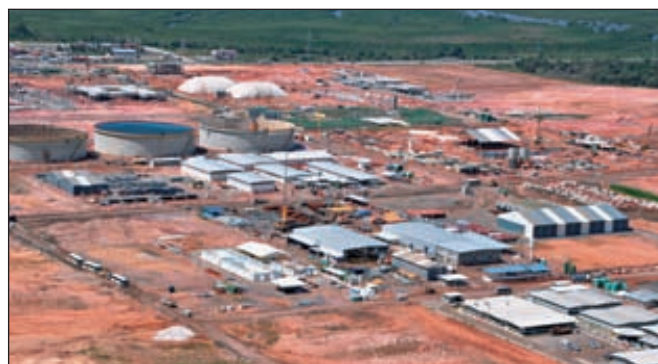
Строительная площадка нового НПЗ Абреу-и-Лима, Бразилия (штат Пернамбуко)
