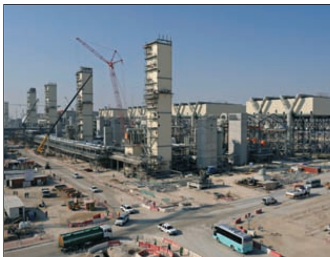
Строительство завода Pearl GTL, Катар, 2010 год
