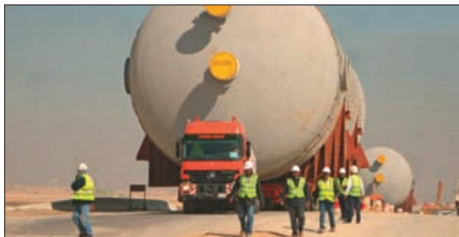
Строительная площадка нефтехимического комплекса компании Satorp, Джубайл (Саудовская Аравия)
