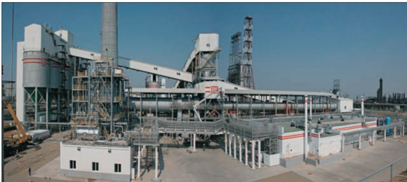
Установка прокатки кокса ОАО «Лукойл-Волгограднефтепереработка»
