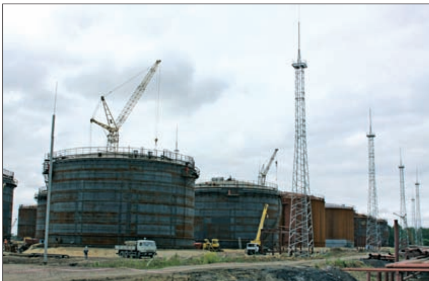
Строительство нового НПЗ
