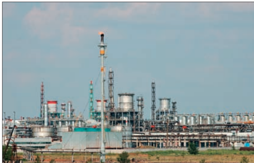
Оренбургский газоперерабатывающий завод
