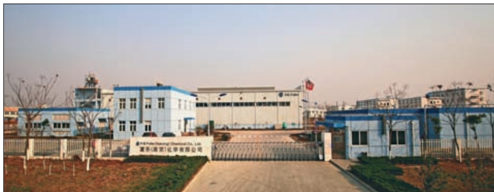
Завод по производству адгезивов компании Н.В. Fuller, Нанкин (Китай)
