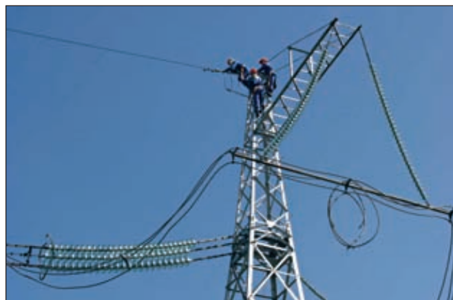
Электросети ФСК ЕЭС. Замена троса на линии электропередачи 330 кВ
