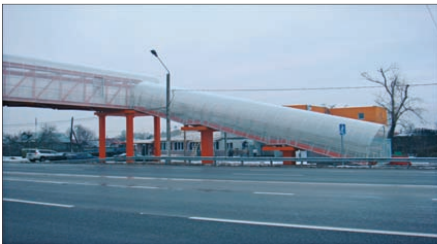
Пешеходный переход с использованием композиционных материалов на 378 км а/д М-7 «Волга» в Нижегородской области
