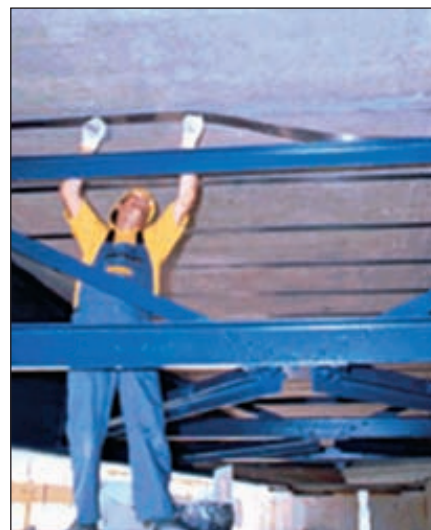
Усиление моста углеродной лентой
