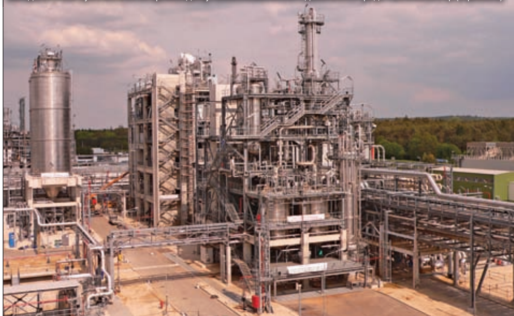
Завод компании LyondellBasell по производству полиэтилена низкого давления в городе Мюнксмюстер (Германия)
