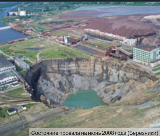
Состояние провала на июнь 2008 года (Березники)
