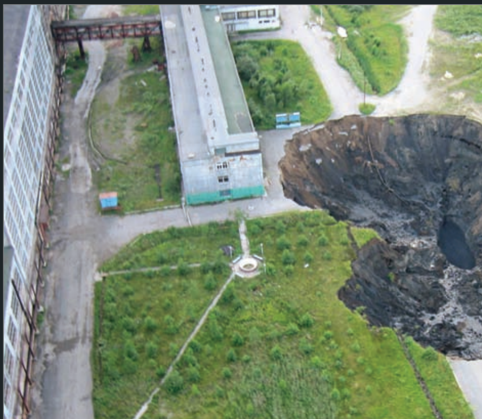
Рис. 1. Провал земной поверхности в конце июля 2007 года на территории БКПРУ-1 ОАО «Уралкалий». Расстояние до города Березники (до первых жилых домов) — меньше 1 км
