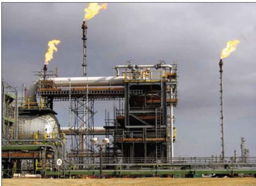
Первый проект казахстанской нефтехимии — строительство газохимического комплекса (на фото месторождение в Тенгизе)
