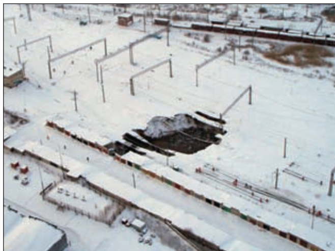
29 ноября 2010 года. Провал грунта в районе железнодорожной станции Березники (Пермский край). Железнодорожный вагон с калийными удобрениями, угодивший в воронку утром 25 ноября, ушел под землю
