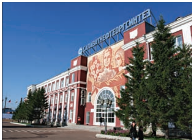
Здание заводоуправления «Салаватнефтеоргсинтез» в городе Салават (Башкортостан)
