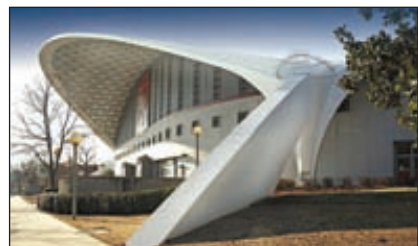
Здание Stegeman Coliseum (США). Его крыша покрыта водонепроницаемым слоем из Kynar®
