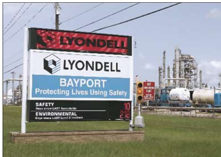
Вход на предприятие Lyondell в Пасадена (Техас, США)
