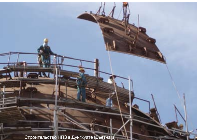
Строительство НПЗ в Дунгкуате (Вьетнам)
