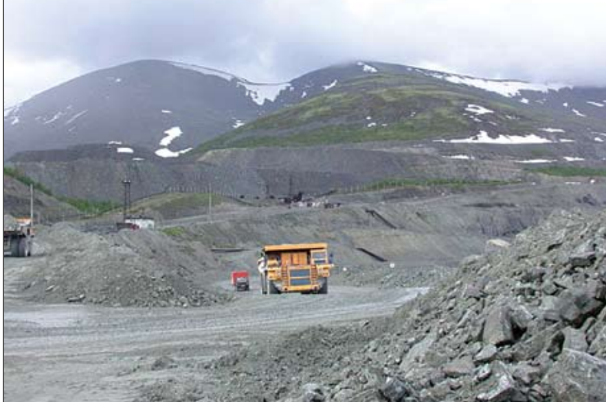
Мощность месторождения Олений Ручей, разрабатываемого СЗФК, составляет 385 млн т. Начало строительства рудника, август 2009 г.
