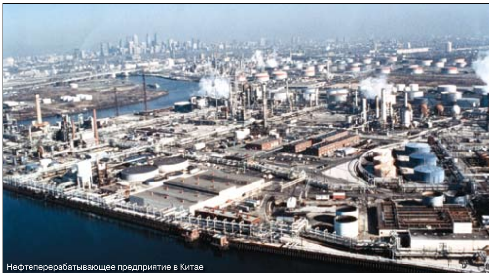
Нефтеперерабатывающее предприятие в Китае
