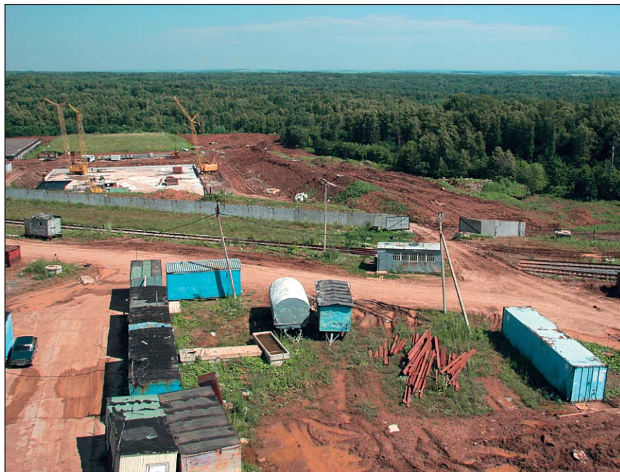
Промышленная площадка ОАО «Полиэф» на этапе строительства в 2005 году
