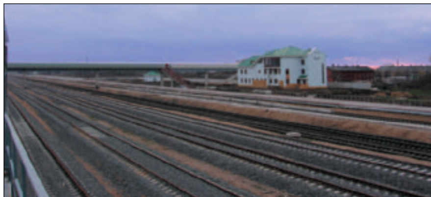
На самом грузонапряженном пограничном переходе с Литвой в настоящее время строится железнодорожная межгосударственная станция Чернышевское, которая увеличит пропускную способность дороги
