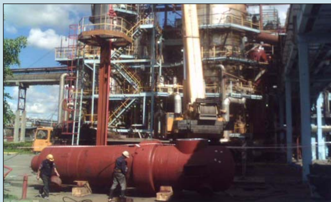
Монтаж испарителей Т-7 на ООО «Тобольск-Нефтехим»
