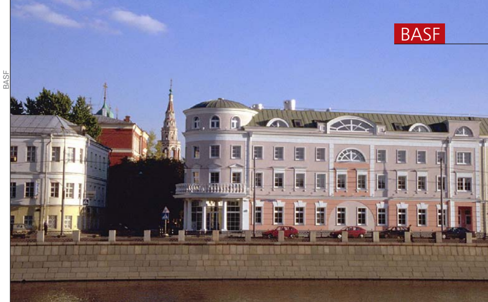
Центральный офис BASF в Москве на Кадашевской набережной
