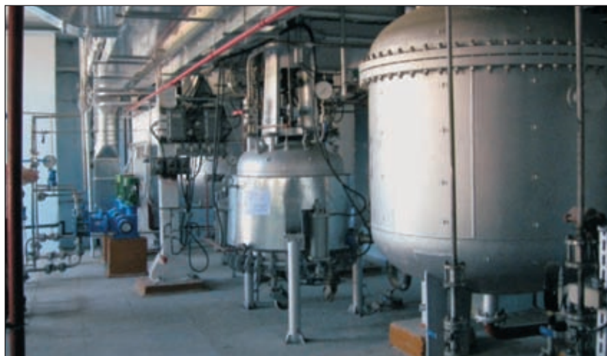
Укрупненная опытная установка по получению ТМК в ООО «Томскнефтехим». В 2008 году наработана и испытана опытная партия ТМК на промышленной линии в производстве ПП. Произведено 250 тонн полипропилена
