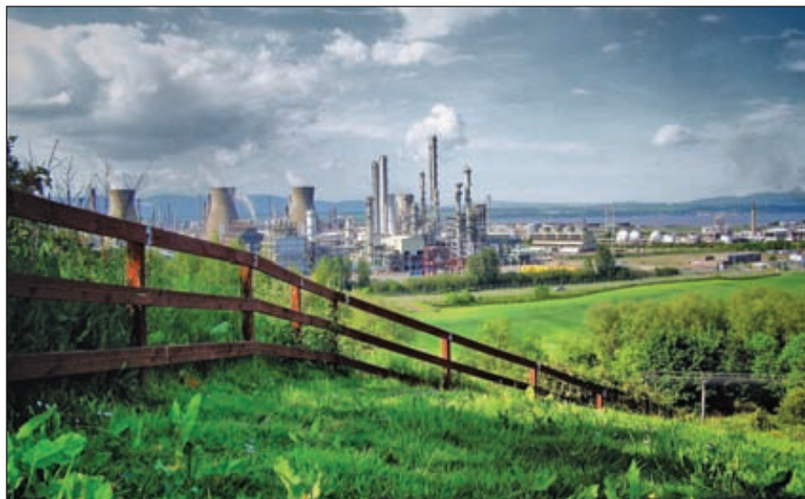
Нефтехимический комплекс Grangemouth — крупнейшее производство компании Ineos. Занимает площадь 1700 акров. На его территории находится единственный НПЗ в Шотландии. Комплекс расположен в 40 км к западу от Эдинбурга (Великобритания). НПЗ Grangemouth производит 200 тыс. баррелей сырой нефти ежедневно и 9 млн литров чистого топлива
