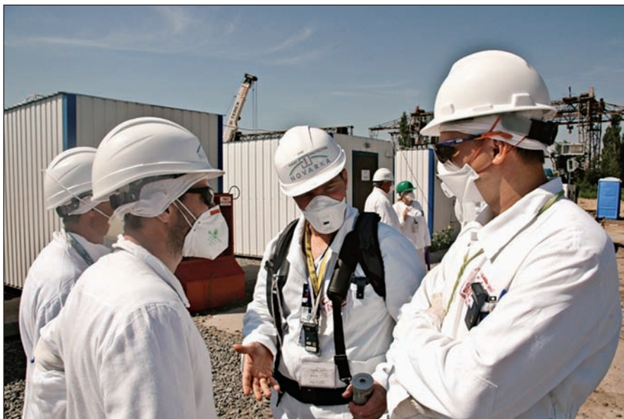
Июнь 2010 года. На ЧАЭС идут работы по строительству фундаментов надстройки нового безопасного контайнмента — защитного сооружения вокруг 4-го блока. Подрядчиком является СП «Новарка» (Франция). Бетонный «саркофаг», построенный в 1986 году, начал разрушаться. По официальным данным, внутри «саркофага» находится 95 % от того количества радиоактивных веществ, которое было на момент аварии
